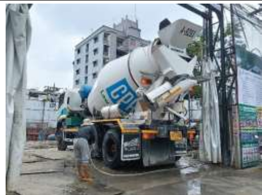
รูปที่ 10 ล้างล้อรถบรรทุก
