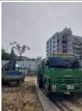
รูปที่ 11 ปูแผ่นเหล็กสำหรับใช้เป็นทางวิ่งรถ
